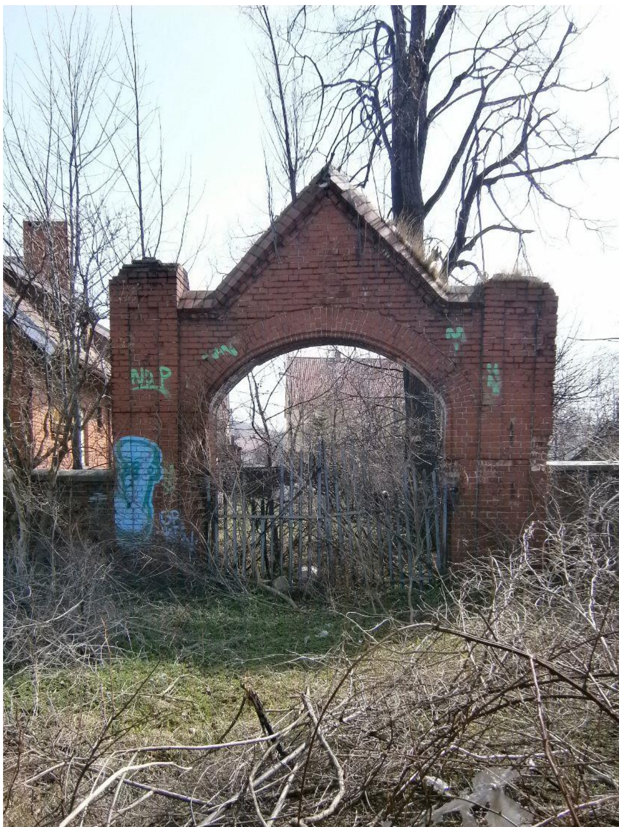
Brama dawnego cmentarza ewangelickiego, ul. Cmentarna
