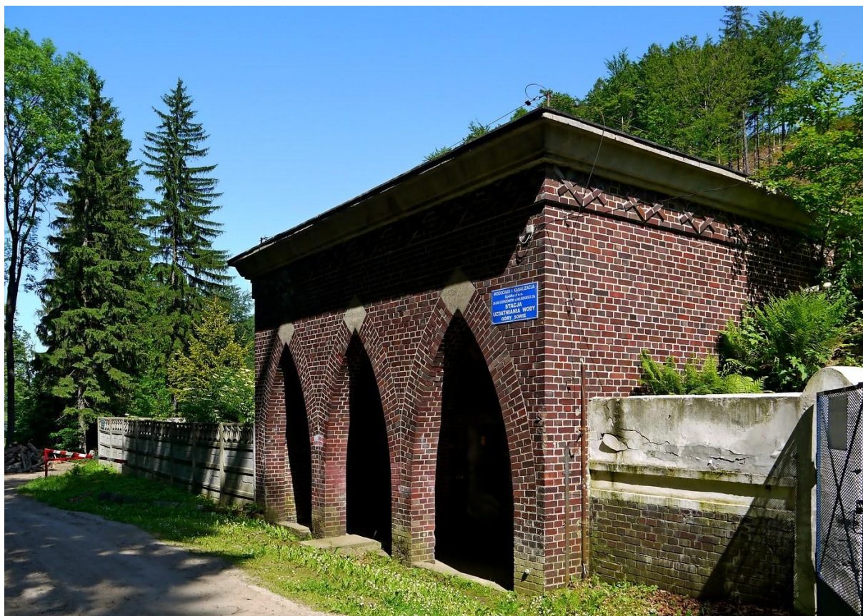
Zbiornik i stacja uzdatniania wody, ul. Nowobielawska
