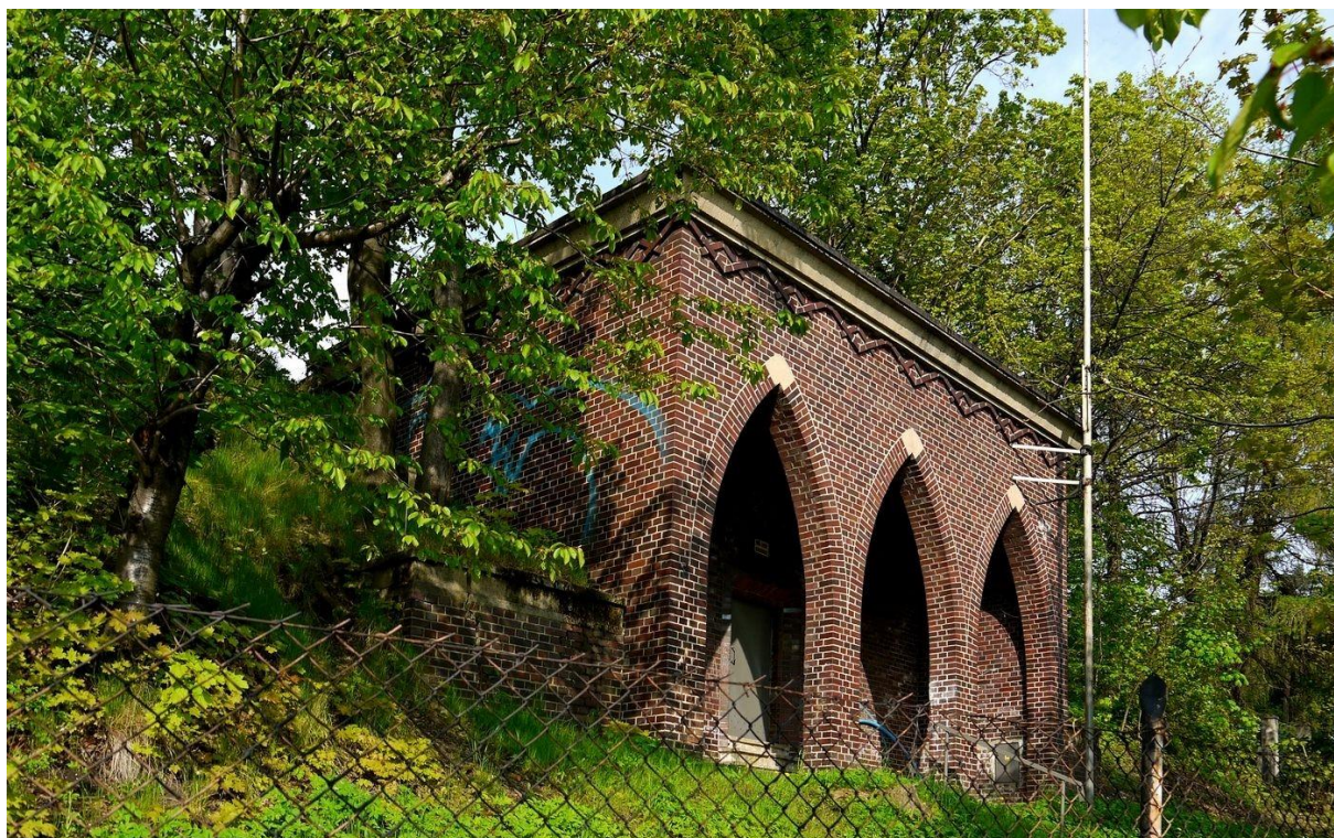
Wodociąg zbiornik Góra Maślana
