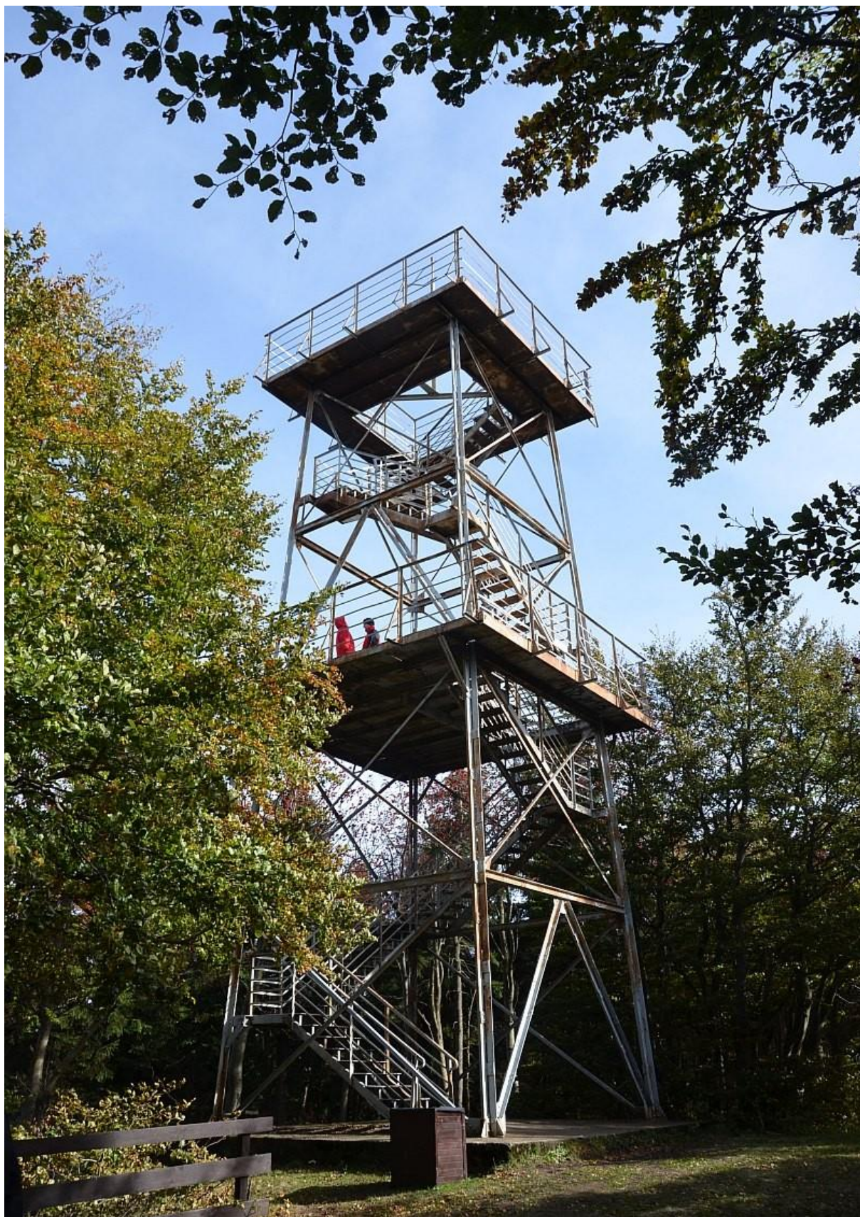
Wieża widokowa na Kalenicy z 1933 r., Góry Sowie
